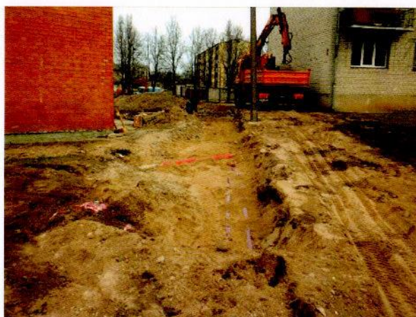
10.att. Aizbērtā tranšeja, ierīkota signāllente II posms
