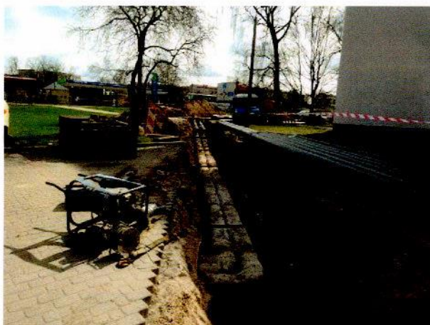
13.att. Esošo siltumtīklu cauruļu atrakšana I posms
