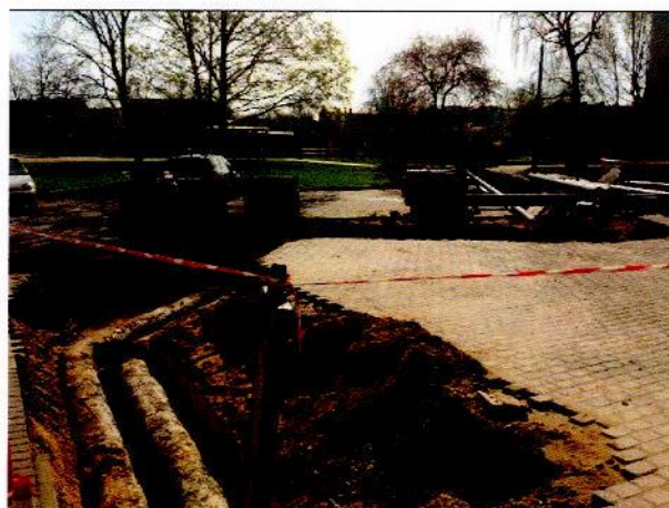
14.att. Esošo siltumtīklu cauruļu atrakšana I posms
