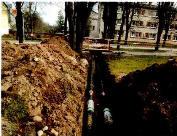
1.att. Tranšējā samontētie cauruļvadi
