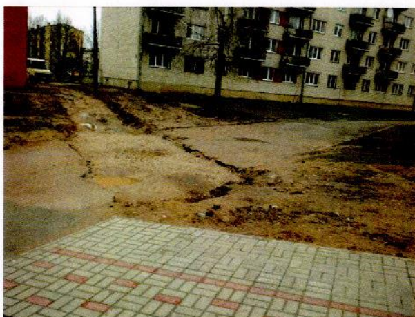
12.att. Atjaunots bruģakmens segums II posms
