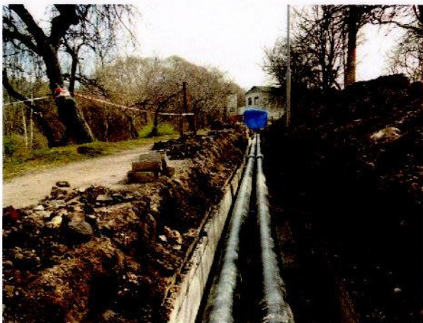
19.att. Cauruļu montāža tranšējā uz pagaidu balstiem
