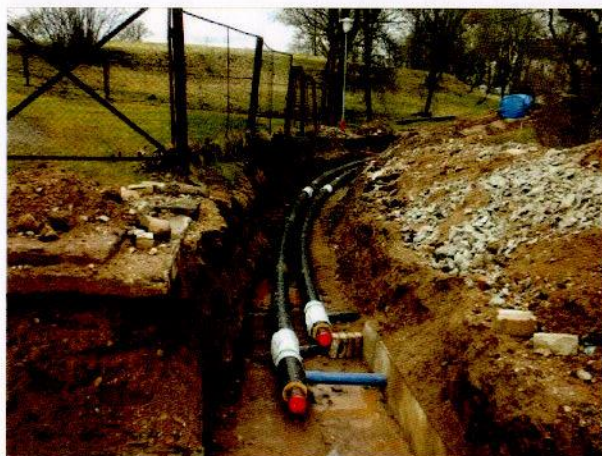
20.att. Rūpnieciski liekto cauruļu montāža tranšējā uz pagaidu balstiem
