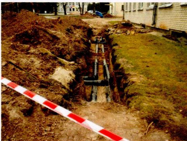
3.att. Tranšējā samontētie cauruļvadi
