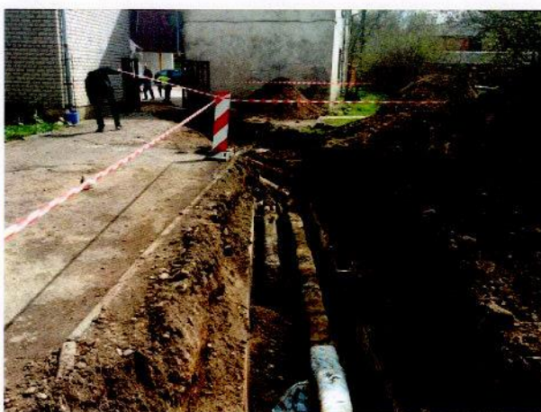
26.att. Tranšejas atrakšana, cauruļu demontāža
