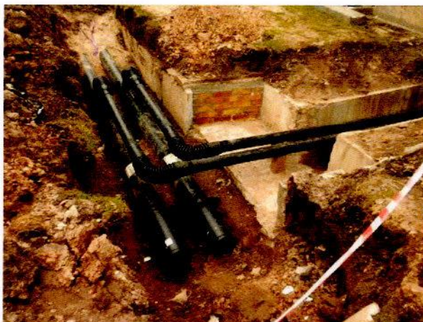
2.att. Tranšējā samontētie cauruļvadi
